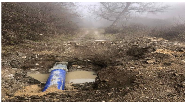
Slika 1. Primjer sanacije puknuća na Bukovici cijev DN 400mm
